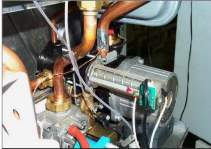
Figura 10: Atuador montado em um boiler. Fonte [11].
